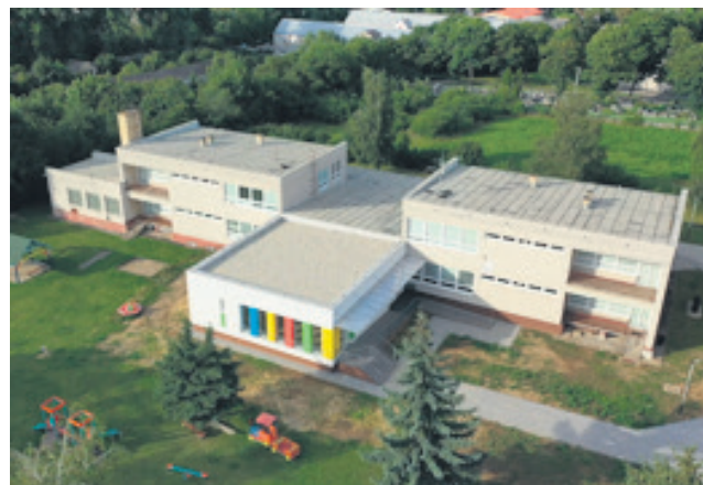
Materská škola s novou prístavbou. Foto: Juraj Škvarka
