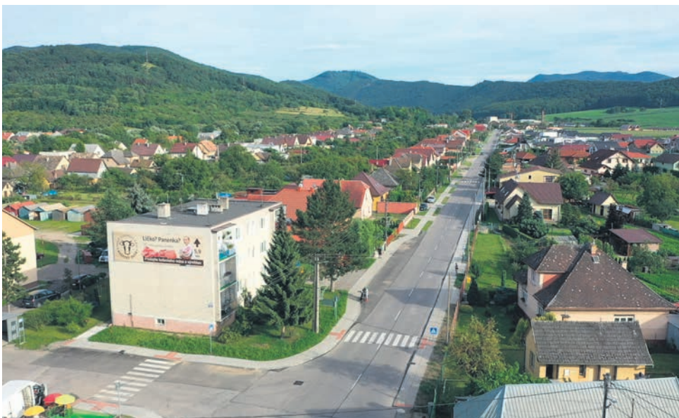
Nové chodníky na Zliechovskej ulici. Foto: Juraj Škvarka
